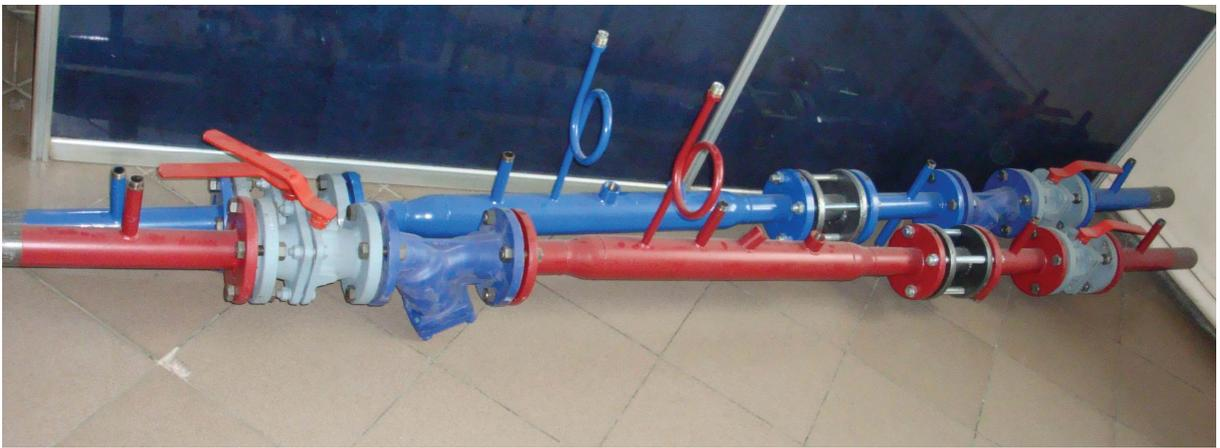
2. **ИЛО** - измерительная линия обратного трубопровода узла учета тепловой энергии в системе отопления, ГВС. Схематично ее можно представить следующим образом:
